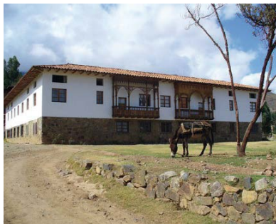
Yanama - panoramica esterna
