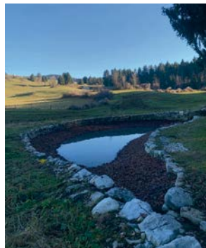
Antica Strada del Costo - Pozza dei Gianot - ripristino
